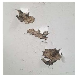
Toiture éventrée protégée par une bâche et traces d'infiltration d'eau sur les plafonds intérieurs
